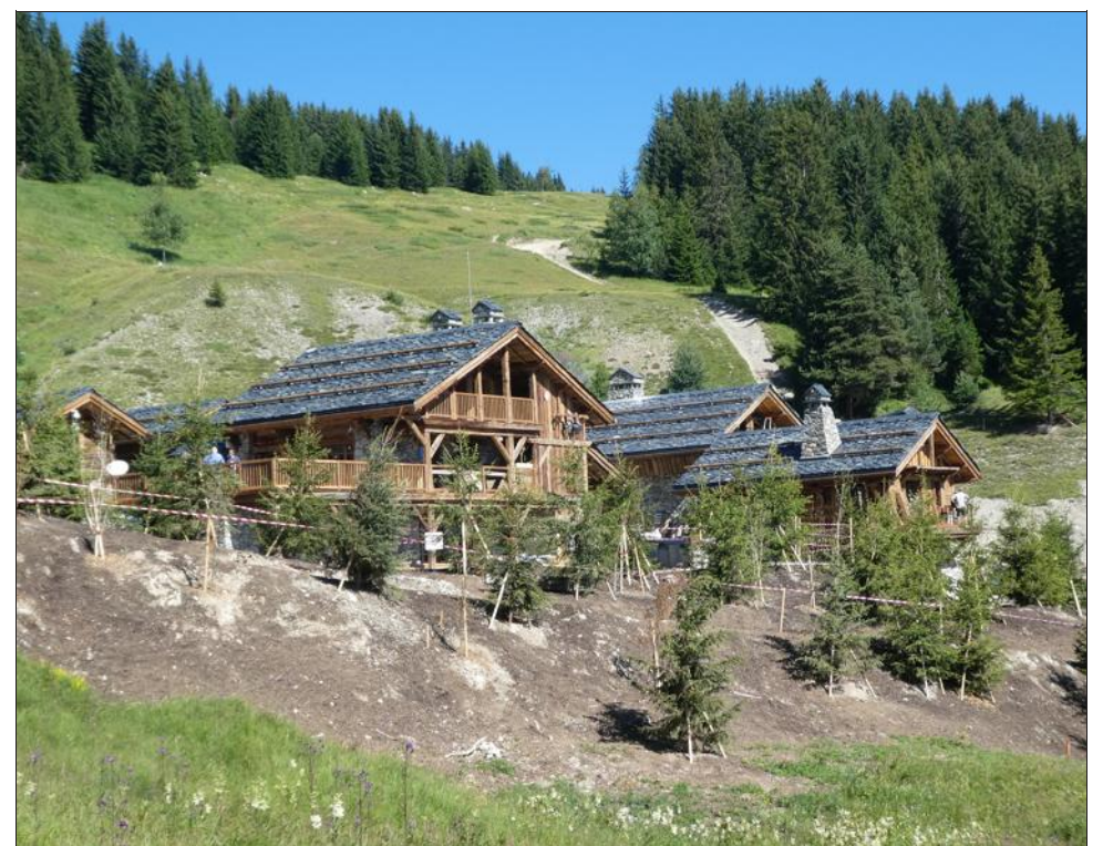
Une vue de l'avancement des travaux extérieurs, mi-juillet.
